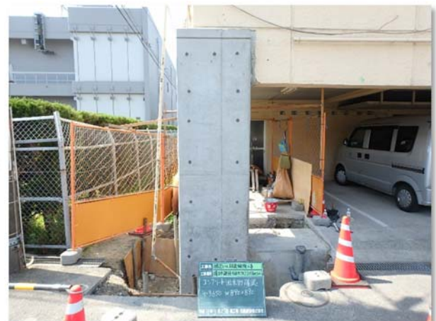
コンクリート打設完了
