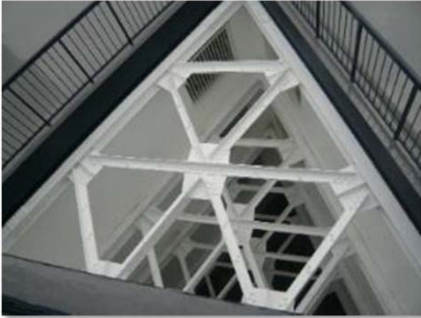
吹抜け部（改修後）
