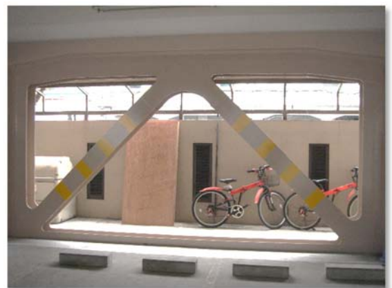
鉄骨ブレース補強
