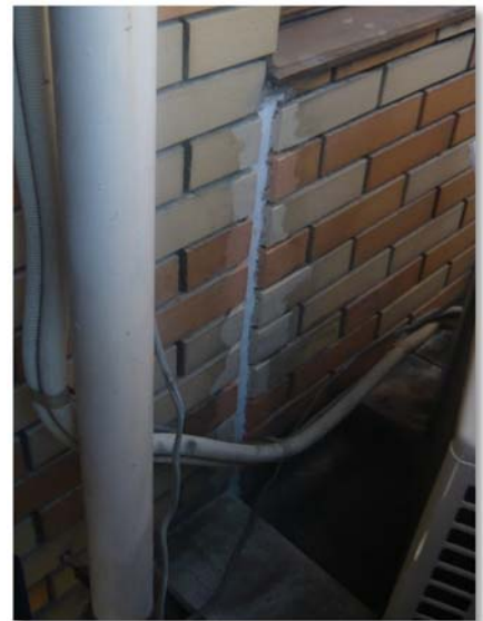
耐震スリット補強
