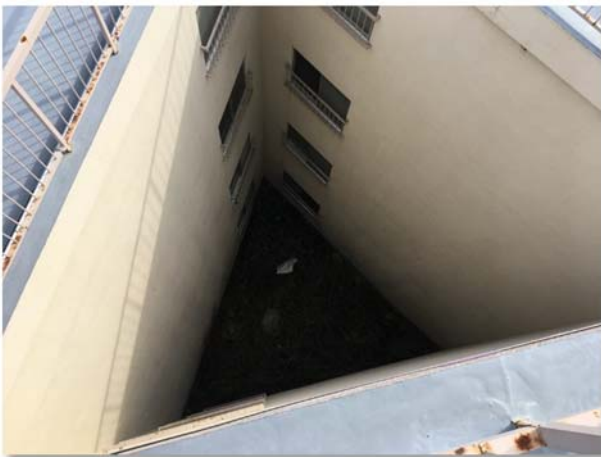
吹抜け部（改修前）
