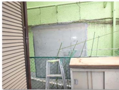
改修後（塗装前）
