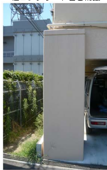
柱コンクリート巻き補強
