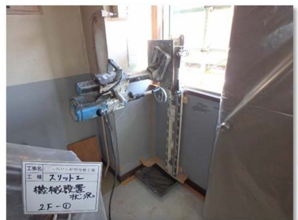
スリット削孔中の様子 低騒音工法を採用
