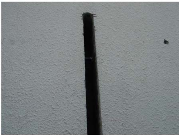
スリット削孔状況
