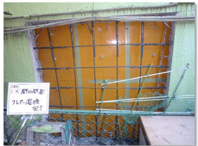
耐震壁開口閉塞補強部の配筋状況
