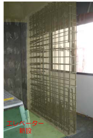
仕上内部の様子（配筋時）
