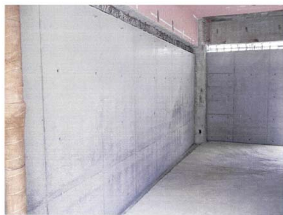
耐震壁の増設
