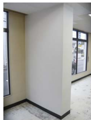
仕上げ復旧後
