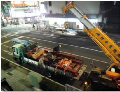
夜間の鉄骨ブレース搬入状況
