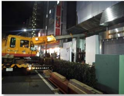
夜間の鉄骨ブレース搬入状況
