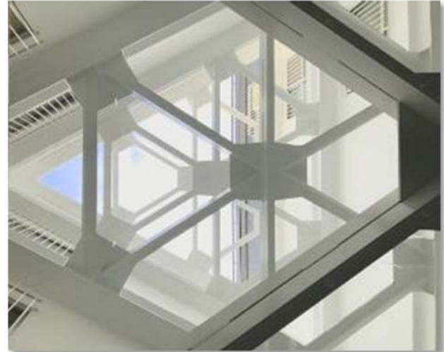
鉄骨水平ブレース補強を見上げた様子 魅せる補強となっている
